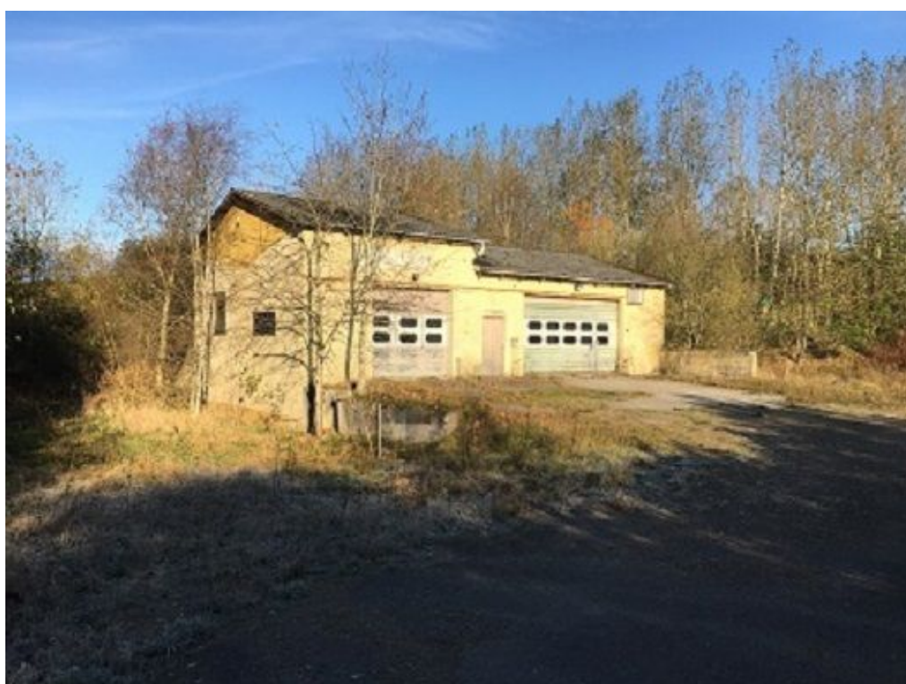
Det gamle mørtelværk
