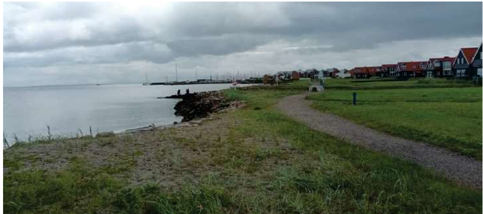
Figur 8-6 Eksempel, der illustrerer hvordan kyststrækningen inden for undersøgelsesområdet fremstår. Området er ikke et egnet levested for markfirben grundet det flade terræn /49/.
