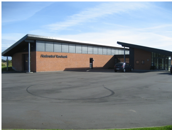
Figur 1: Hedensted Vandværk. Foto fra tilsyn i 2010.
