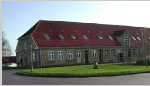
Herregårdens tidligere avlsbygninger rummer nu beboelser og andre faciliteter for de indsatte.
