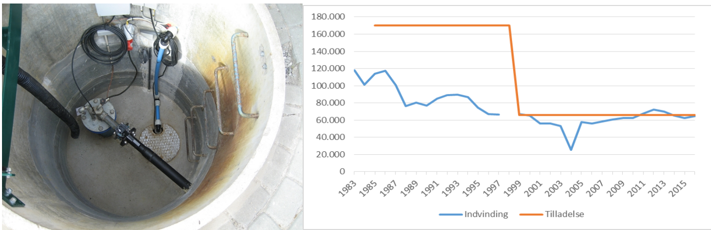
Figur 2: Indvindingsboring DGU nr. 116.1629 samt kurve med indvindingsmængde (til 2016).
