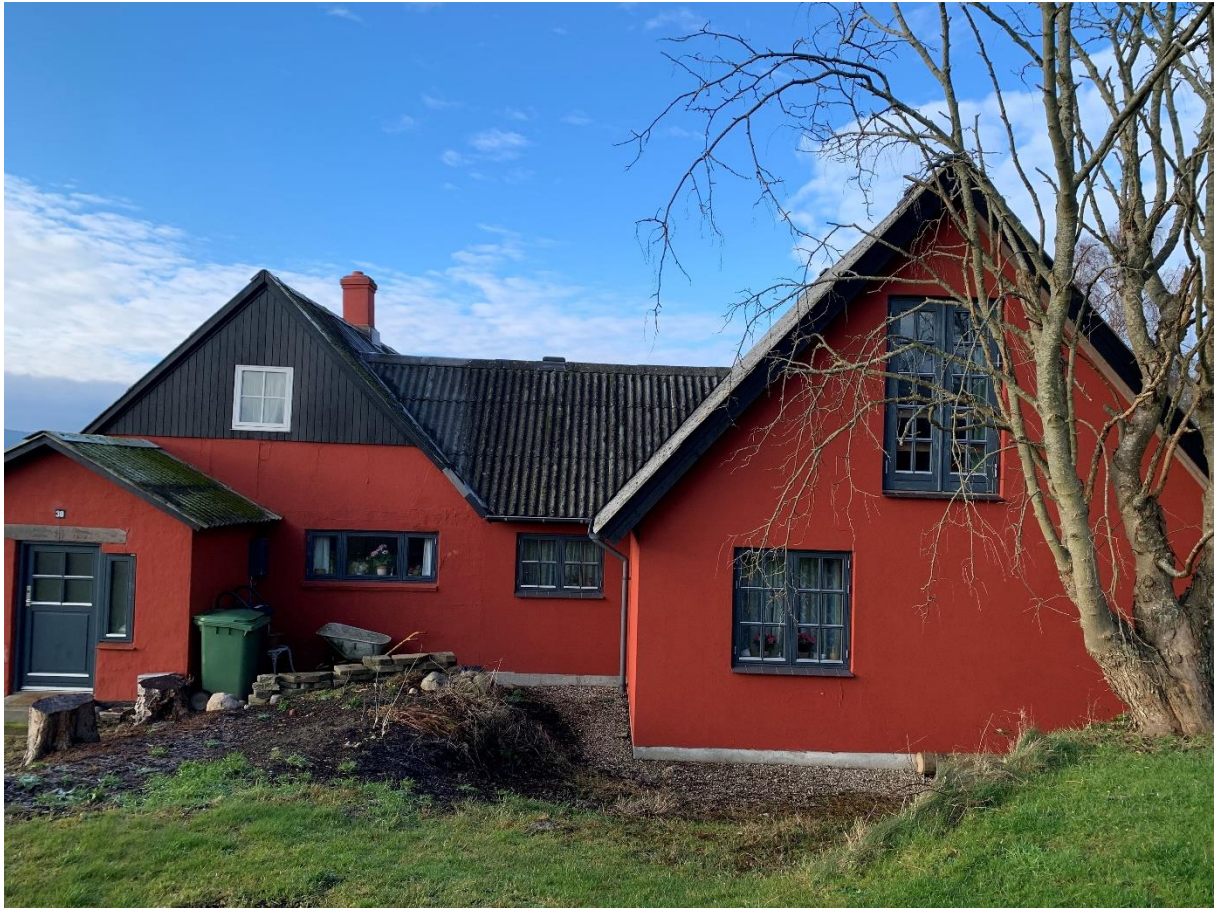
Eksisterende bolig set fra øst
