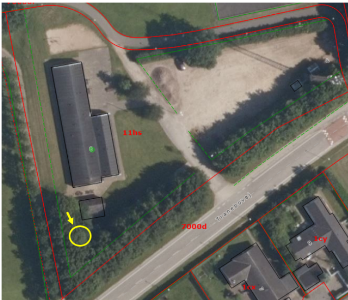
Den omtrentlige placering af det ansøgte vist med gul cirkel på luftfoto fra 2024
