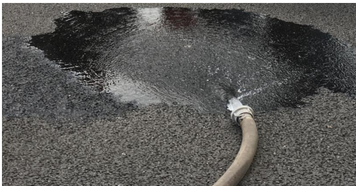
Billede 4 Permeabel asfalt er fast overflade hvor vandet kan sive igennem. Foto Hedensted kommune
