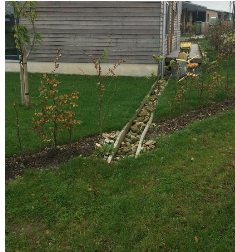
Regnvand ledes i en tæt rende fra bygnin- gen til nedsivning i græsplænen. Foto Hedensted kommune
