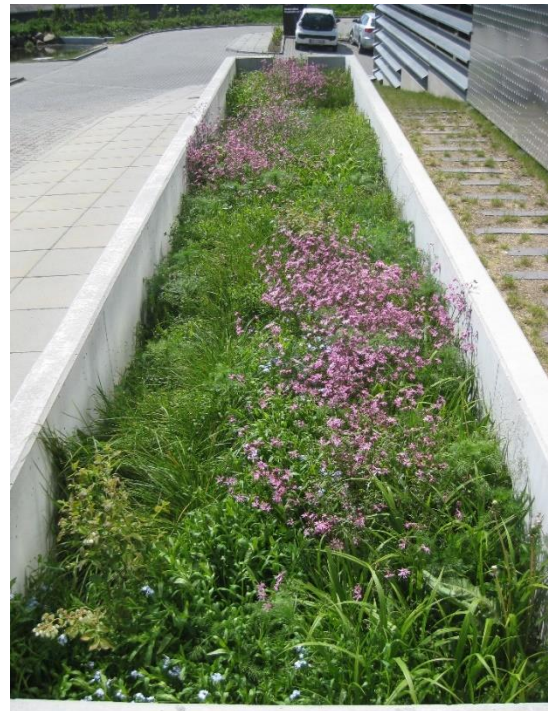
Billede 2 Regnvandsbed med overløb til opsamlingsareal på parkeringsområde. Foto DANVA
