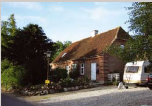
På Stevnsvej 8 ligger en ældre velholdt murmestervilla i rød tegl, karakteristisk for perioden med »Bedre Byggeskik«.
