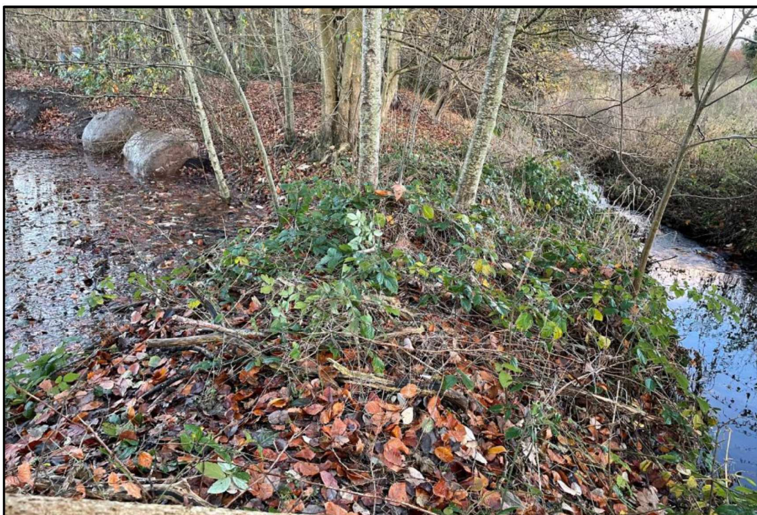
Fotos , der viser udløb fra forsinkelsesbassin til område mellem bassinet og vandløbet Til-løb til Torup Bæk, hvor udløbet nedsiver og over en ca. fem meter lang strækning langs vandløbet diffust udledes i vanløbet. Ansøger har ansøgt om at sænke brinken for at styre udlodningen i vandløbet samt om at stabiliseres vandløbets brink med beton og håndsten sat i betonen. Afgørelsen indeholder tilladelsen til det ansøgte udløbsbygværk.
