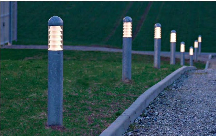
Figur 2.7 Pullerter der anvendes som belysning ved de to parkeringsområder.
