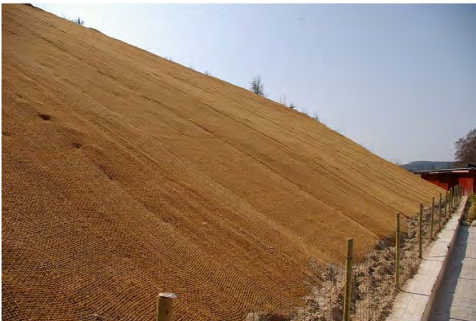
Figur 2.17 Eksempel på brug af kokosnet på skråninger. På det konkrete projekt vil der tilføjes beplantning for at sikre mod erosion.
